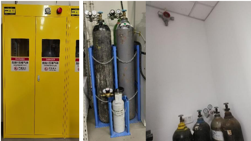
图 7 用气瓶柜 (内含用于固定用带子) (左)、钢瓶架 (或链条) (中) 固定钢瓶和气体报警器 (右)。
